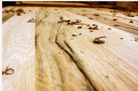
Grob ausgearbeitete Risse
